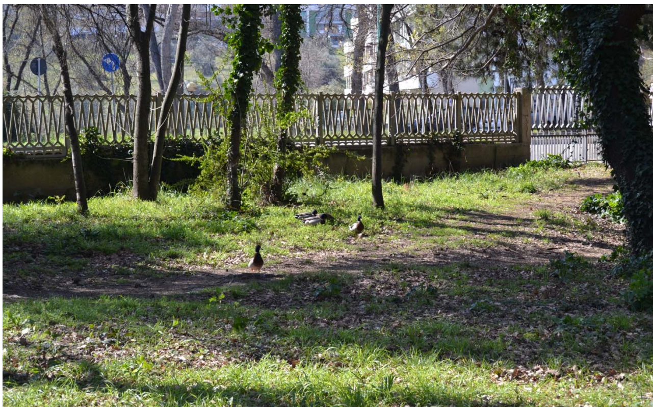
Vista di una porzione della recinzione in muratura e della cancellata dall'interno della Riserva.
